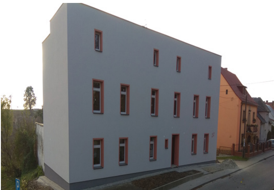
Termomodernizacja budynku mieszkalnego, Sławików ul. Parkowa 22
