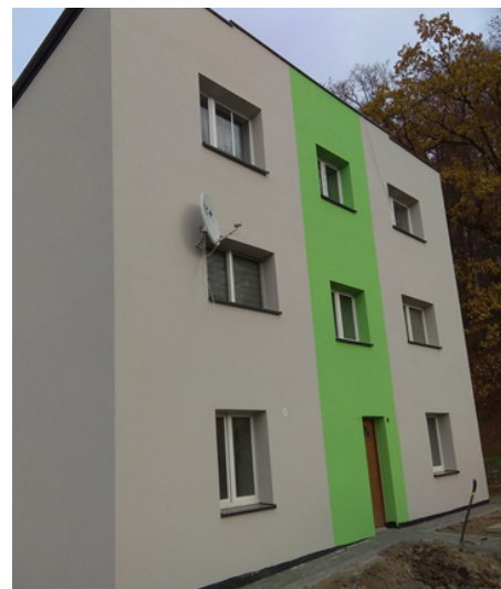
Termomodernizacja budynku mieszkalnego, Jastrzębie ul. Raciborska 1
