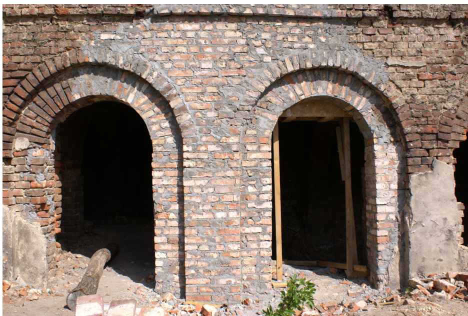
Odbudowa ściany oranżerii w pałacu sławikowskim
